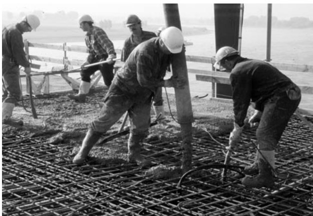
Bild 1: Verarbeiten von Beton auf der Baustelle
